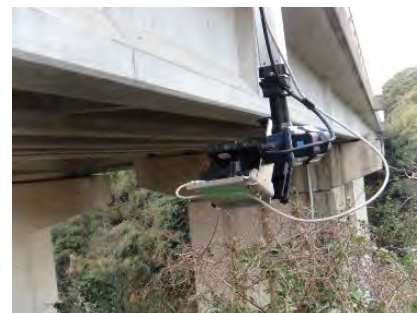
懸垂型架台に設置したレーザースキャナ
