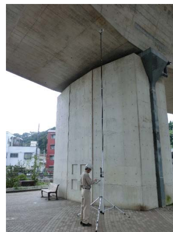
写真3 高所型を用いての点検
