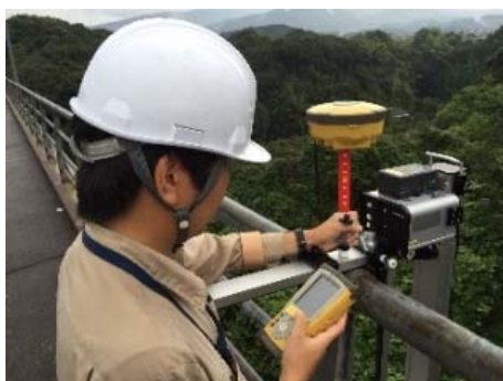
写真 1 GPS 機器と点検ロボットカメラの連動
