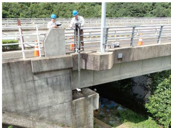
ロボットカメラ(懸垂型)を用いた桁端部のモニタリング状況
