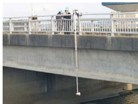
写真4 懸垂型を用いての点検
