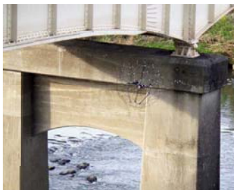
実橋梁での点検試行
