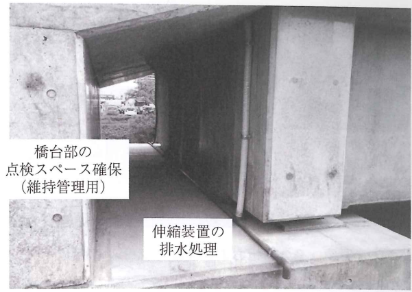
写真 - 4 維持管理性の高い桁端部
