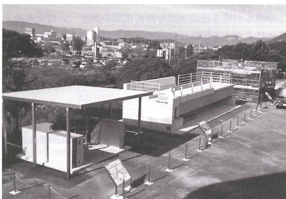
写真 - 1 インフラミュージアム全景
