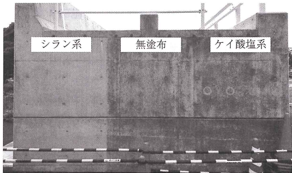
写真 - 7 表面含浸材が塗布された橋台（降雨後）
