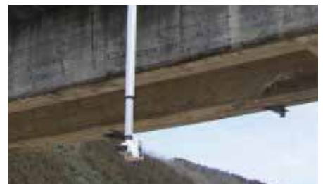
ロボットカメラを用いた橋梁点検
