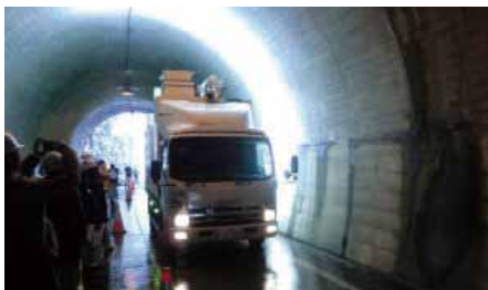
高速走行車両を用いたトンネル点検
