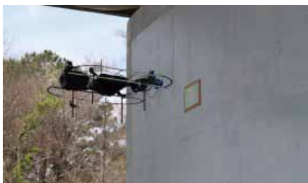
点検ロボットを用いた橋梁点検
