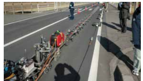
舗装と盛土構造の点検
