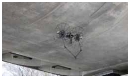
点検ロボットを用いた橋梁点検
