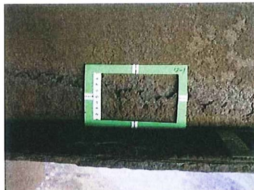
写真2 経過37年 さびの大きさが最大5mm以上、錆が剥がれかかっている
