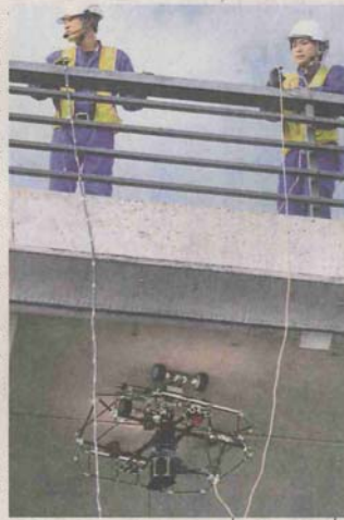
ドローンによる点検も道半ば（岐阜県各務原市）
