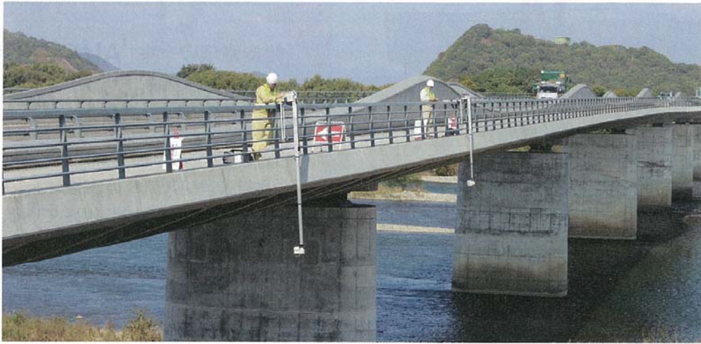
写真1 ■ 橋の上からロボットカメラを垂らして、近接目視が困難な箇所を撮影する(写真:岐阜大学)
