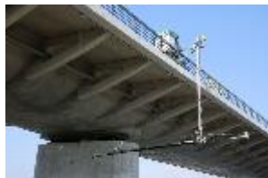
(d) 橋梁点検カメラシステム
