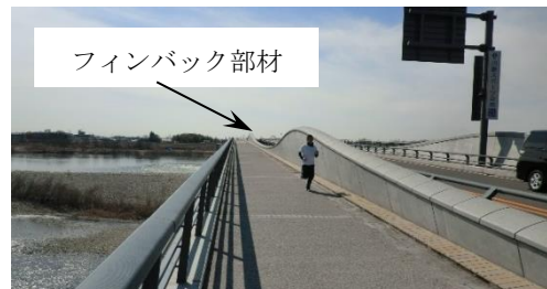
写真-3 各務原大橋の歩車道境界部
