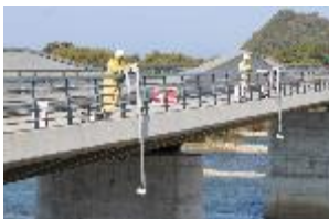
(c) 橋梁点検ロボットカメラ
