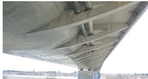
(b) 主桁・ブラケットの構造
