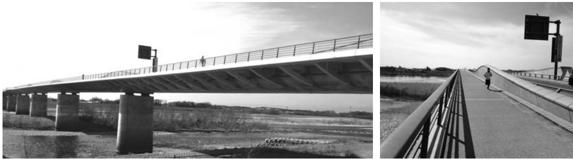
写真-1 各務原大橋
