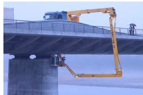
図-7 超大型橋梁点検車のフィールド試験
