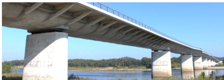
図-1 各務原大橋(左岸側より)
