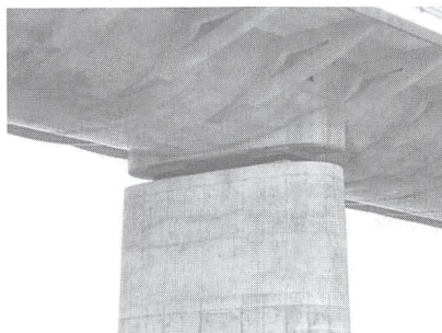
写真-3 張出し部のない橋脚構造
