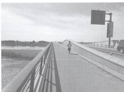
写真-2 自転車歩行者道部とフィンバック部材
