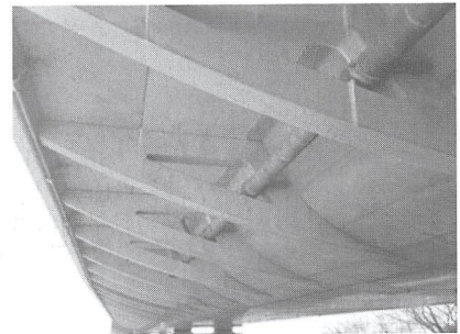
写真-4 自転車歩行者道部ブラケット構造
