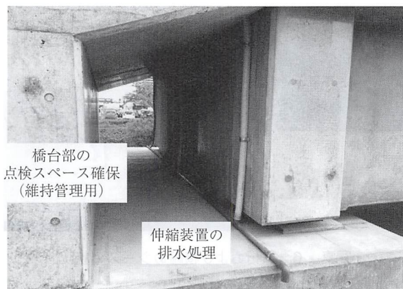
写真 - 4 維持管理性の高い桁端部
