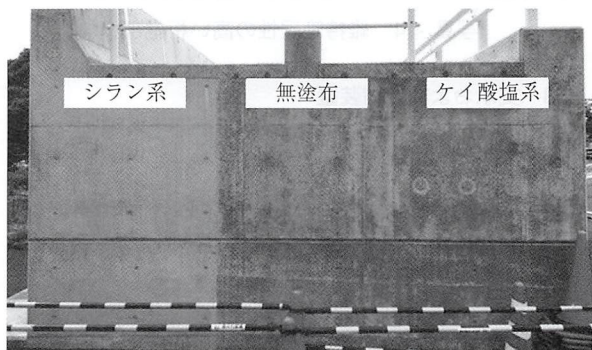
写真 - 7 表面含浸材が塗布された橋台 (降雨後)
