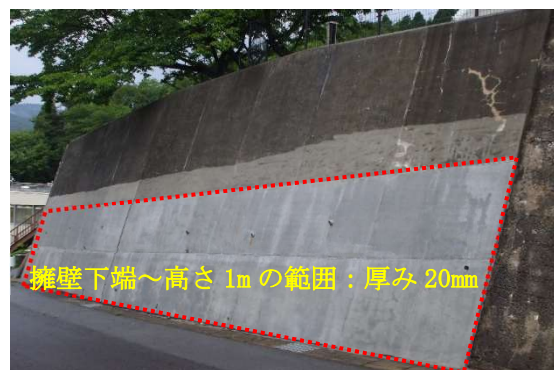
図-2 HPFRCC薄層吹付け施工
