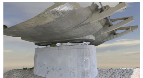
ボート型ドローンで取得した河床および前方の橋脚の状況（サンプルデータ）
