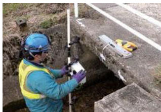
地覆撮影状況
