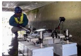
床版撮影状況
