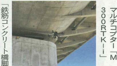
橋台の橋台部では、下部工を点検するロボットカメラ技術として前述の「視る・診る」と小型の「視る・診る mini」の実演、加えて撮影データを3D化し点検、変状調査、補修設計用調査まで可能な「マルチカメラシステム」(開発はシビル調査設計)について説明された。
